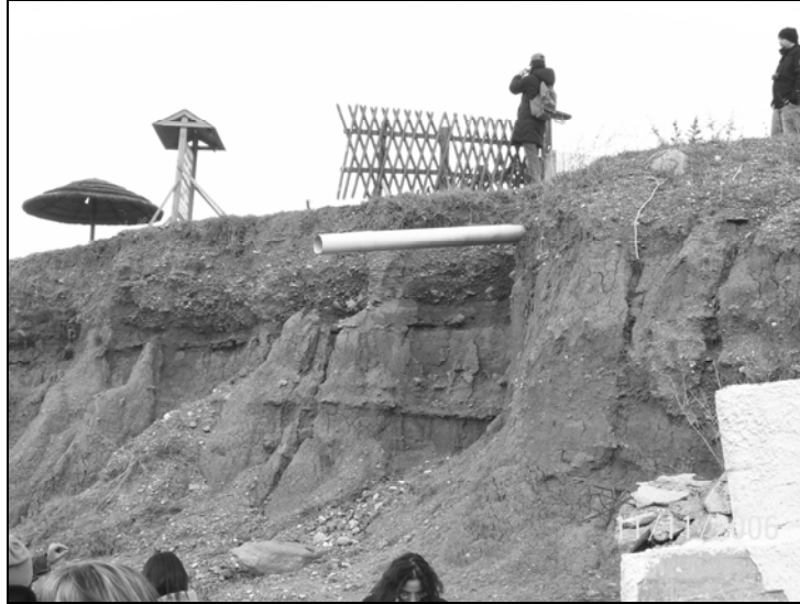
Σχήμα 4. Φωτογραφία από τις ακτές δυτικά της Αλεξανδρούπολης (Σωλήνας που εκβάλλει στη θάλασσα αποκαλύφθηκε λόγω του φαινομένου της διάβρωσης) Figure 4. Photo of western coasts of Alexandroupolis: Pipe which discharges into the sea is uncovered due to the phenomenon of erosion
